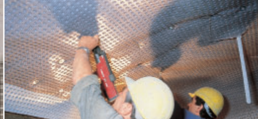
Em túneis, DELTA®-PT suporta aplicações de betão projectado.
