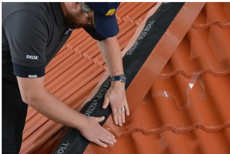
**O DELTA<sup>®</sup>– ECO ROLL pode ser instalado de forma simples e rápida, em sistemas de coberturas ventiladas a seco. A sua seção efetiva de ventilação garante a circulação de ar.**
